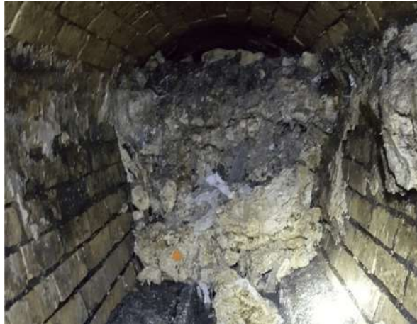
Imatge d'una obturació d'un col·lector causada per olis, greixos, tovallolletes i impropis (fatberg). Font: https://desatascozaragoza.com/por-que-los-fatberg-atascan-las-tuberias/
