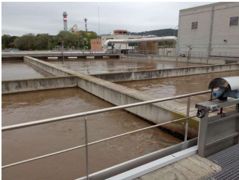
Imatge d'un reactor biològic ple d'aigües residuals i bacteris
