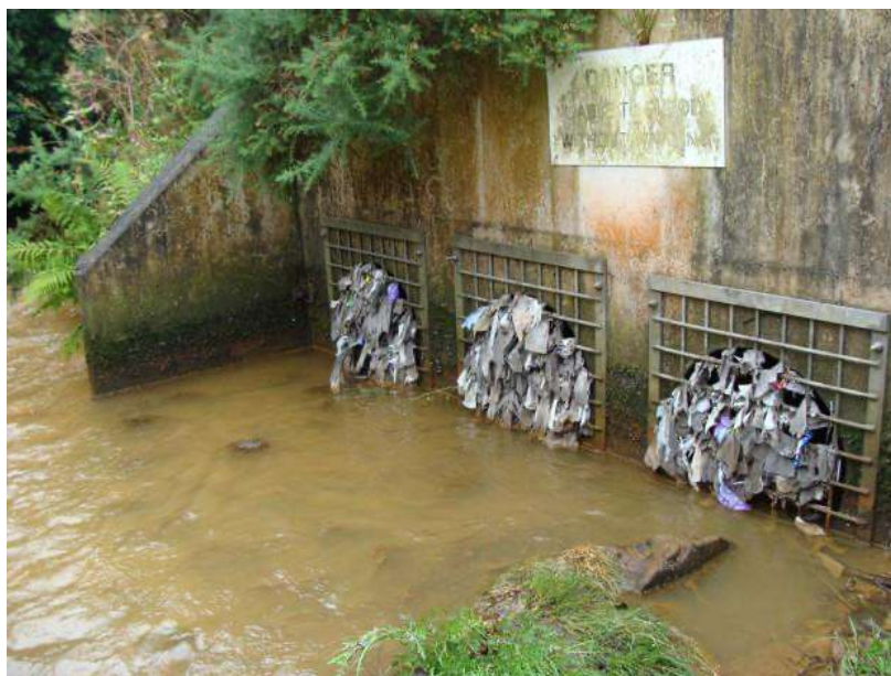
Foto d'un riu amb descàrrega de col·lector unitari després d'un episodi especial de vessament d'aigües residuals dels col·lectors durant una forta pluja
